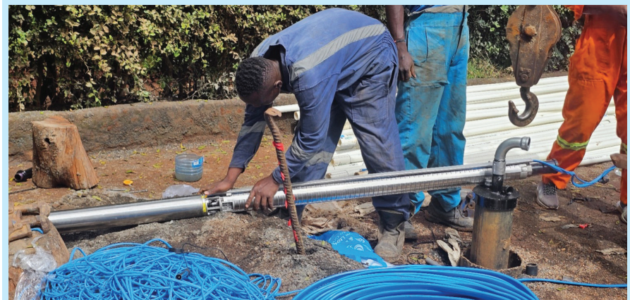
Die Lehrlinge des Gentiana Technical Colleges kommen zum Einsatz, wenn es um elektrische Arbeit geht: Anschluss des Tiefenkabels an die Pumpe (oben), Montieren des Wechselrichters, der den solar erzeugten Gleichstrom in Wechselstrom umwandelt (Bild links), Installieren der Solarpanels auf dem Dach des Bürotrakts (Bild unten).
