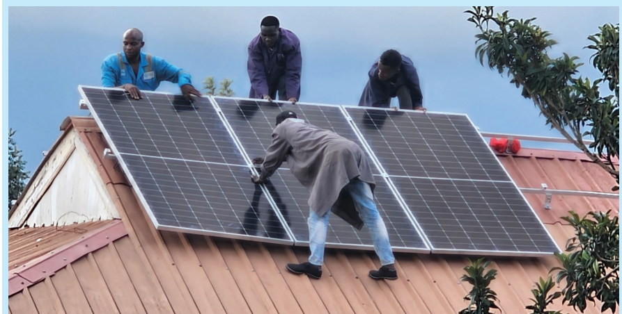
Die Lehrlinge des Gentiana Technical Colleges kommen zum Einsatz, wenn es um elektrische Arbeit geht: Anschluss des Tiefenkabels an die Pumpe (oben), Montieren des Wechselrichters, der den solar erzeugten Gleichstrom in Wechselstrom umwandelt (Bild links), Installieren der Solarpanels auf dem Dach des Bürotrakts (Bild unten).
