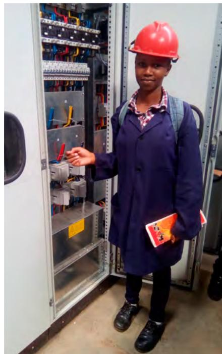
*Rosemary Wambui vor einer Schaltanlage, die bei Stromausfall automatisch den Generator anspringen lässt und die Spannungen reguliert.*
