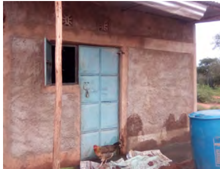
Urbanus: Kornspeicher, gesichert gegen Mäuse, Hühner und Diebe
